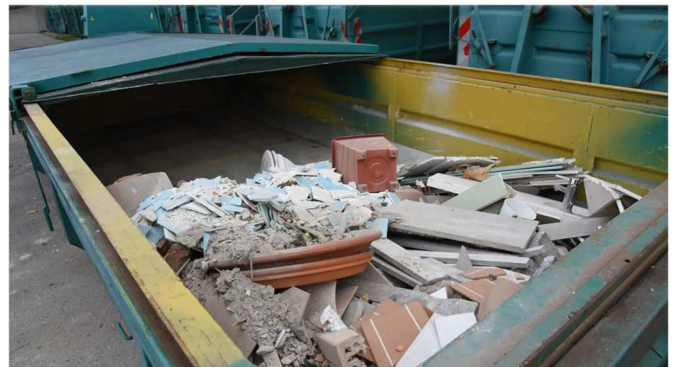
Aufgrund der neuen Recyclinggips-Verordnung müssen Gipsabfälle getrennt von Bauschutt entsorgt werden.
