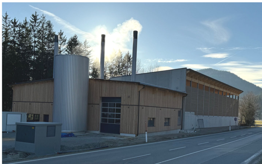
Seit ca. 3 Monaten ist das neue Fernheizwerk in Betrieb und versorgt seither zahlreiche Kunden.
